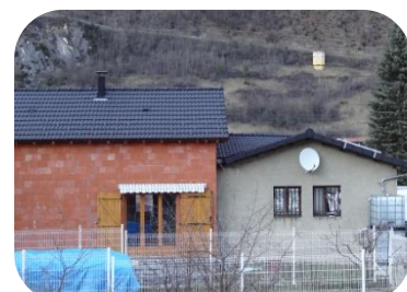
Architectures périphériques à Auzat- PNR
