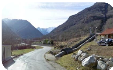
Conduite forcée à Auzat
