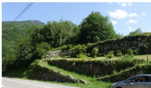
Ouverture mettant en valeur le patrimoine des terrasses à Laramade (ouverture réalisée sans l'accompagnement du Parc)
