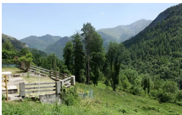
Ouverture à Suc ayant permis de désenclaver le village et ouvrir sur la vallée
